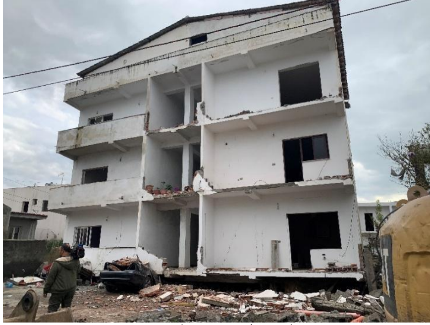
تصویر (۴): اس مکان کی سب سے نچلی منزل کمزور / لچک دار تھی، جو ایک درمیانے درجے کے زلزلے میں تباہ ہو گئی۔ (N. Vesho)
