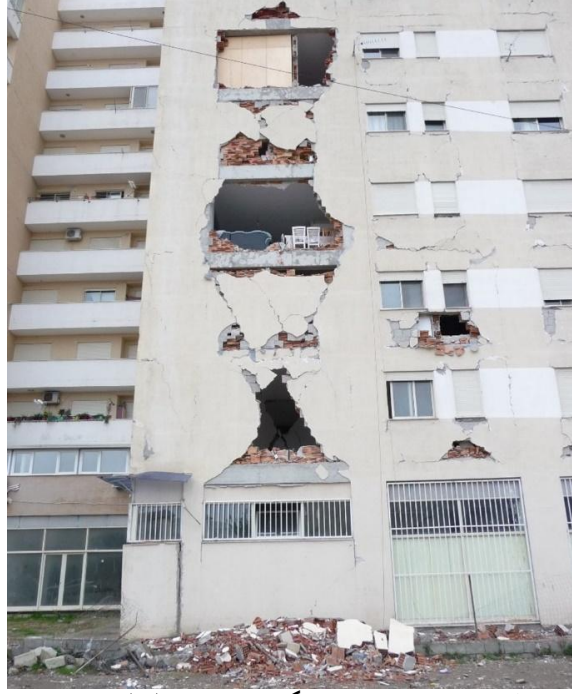
تصویر (۲): اگر ڈیزائن صحیح طریقے سے نہ کیا گیا ہو، تو زلزلے کے دوران مکان کے اندر اینٹ کی دیواروں کو کافی نقصان پہنچ سکتا ہے۔
