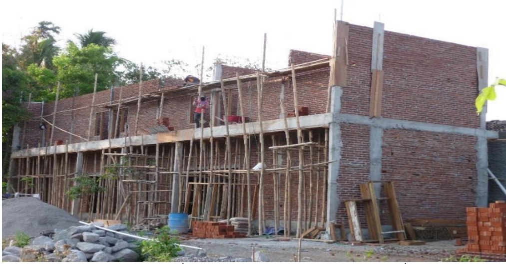
تصویر 3- مضبوط کنکریٹ (reinforced concrete) اور اینٹ سے ایک محصور چنائی (confined masonry) عمارت کی تعمیر۔
